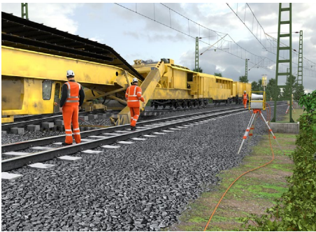
Abb. 23 Maschinenbediener im Nachbargleis: Empfehlung Warnkleidung Klasse 3
