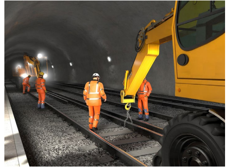
Abb. 24 Beschäftigte im Arbeitsbereich von Gleisbaumaschinen: Empfehlung Warnkleidung Klasse 3
