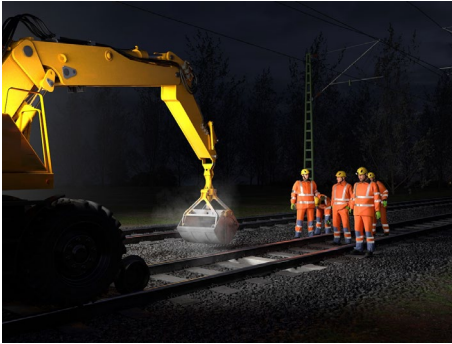
Abb. 22 Gleisoberbauarbeiten: Empfehlung Warnkleidung Klasse 3
