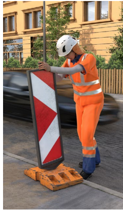
Abb. 14a und b Einfache Gefährdung: Rundbundhose C3 in Kombination mit T-Shirt B oder nur T-Shirt B, Straßenverkehr im Baustellenbereich 30 km/h, mindestens Warnkleidungsklasse 2
