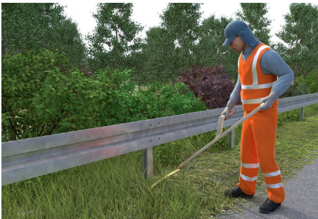
Abb. 15 Erhöhte Gefährdung, Warnkleidung Klasse 3, a: Latzhose oder Rundbundhose mit Warnweste A, b: Rundbundhose oder Latzhose mit Jacke D
