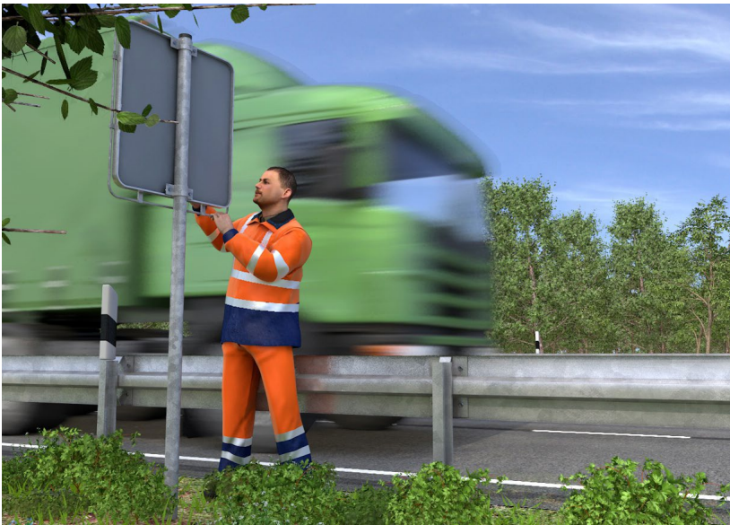
Abb. 1 Gefahr des unbeabsichtigten Hineingeratens in den fließenden Verkehr
